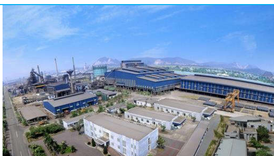
Dự án: Nhà máy sản xuất gang thép Hòa Phát Dung Quất Gói thầu: Hệ thống cơ điện Khách hàng: Công ty cổ phần tập đoàn xây dựng Hòa Bình Giá trị: 29.9 tỷ VNĐ Thời gian: 2017
