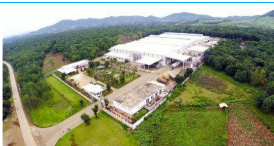
Dự án: Nhà máy sữa TH Milk Gói thầu: Hệ thống điện trực Khách hàng: Công ty cổ phần thực phẩm sữa TH Giá trị: 15 tỷ VNĐ Thời gian: 2015
