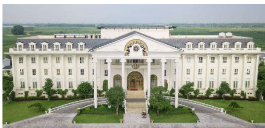
Dự án: FLC Vinh Thinh Resort Gói thầu: Hệ thống cơ điện Khách hàng: Công ty cổ phần dịch vụ kỹ thuật Giá trị: 22.1 tỷ VNĐ Thời gian: 2016
