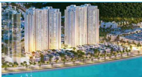
Dự án: DOJI Hạ Long Gói thầu: Hệ thống Điện, điện nhẹ Khách hàng: Công ty TNHH đầu tư xây dựng Unicons Giá trị: 37.6 tỷ VNĐ Thời gian: 2019
