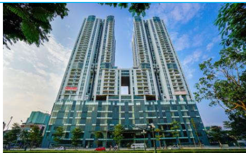
Dự án: HUD New Skyline Gói thầu: Hệ thống tủ điện Khách hàng: Công ty cổ phần dịch vụ kỹ thuật Giá trị: 18 tỷ VNĐ Thời gian: 2016
