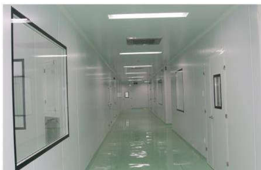
Hệ thống lạnh công nghiệp – Hệ thống kho lạnh Industrial cooling system – Cold storage system
