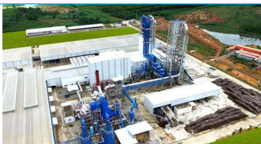
Dự án: Nhà máy gỗ MDF Nghệ An Gói thầu: Hệ thống tủ điện + Busway Khách hàng: Công ty cổ phần kỹ nghệ điện chiếu sáng Việt Nam Giá trị: 23.3 tỷ VNĐ Thời gian: 2015
