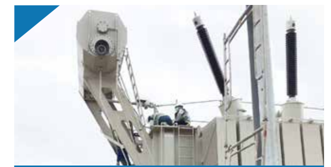
LẮP ĐẶT MÁY BIẾN ÁP/ TRANSFORMER INSTALLATION
