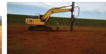
Máy đóng lỗ móng giá đỡ tấm pin Foundation pile driver of PV panel bracket
