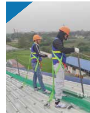
Lắp đặt lưới an toàn xung quanh mái trước khi thi công Install safety net around the roof before construction
