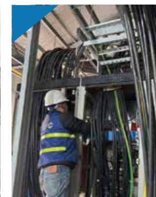
Kiểm tra và sửa chữa hệ thống Inspect and repair
