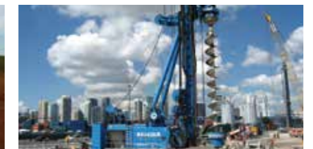
Máy khoan tạo lỗ móng giá đỡ tấm pin Foundation hole driver of PV panel bracket
