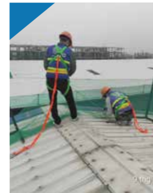
Lắp đặt lưới an toàn xung quanh mái trước khi thi công Install safety net around the roof before construction
