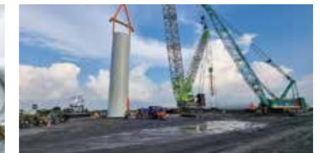
Mũi thi công điện gió Erecting wind turbine and logistics
