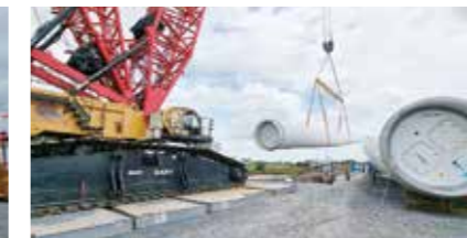
Mũi thi công điện gió Erecting wind turbine and logistics
