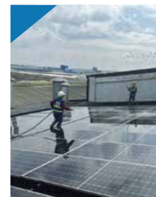
Công tác rửa pin định kì Periodic PV panel cleaning
