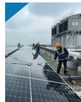
Công tác rửa pin định kì Periodic PV panel cleaning
