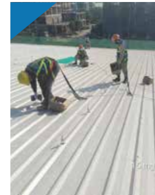
Mái tôn Corrugated roof
