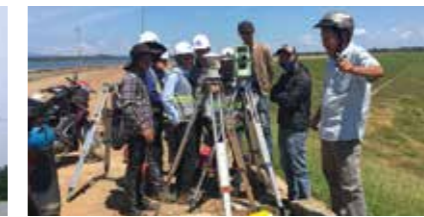
Công tác trắc địa công trường Site surveying work
